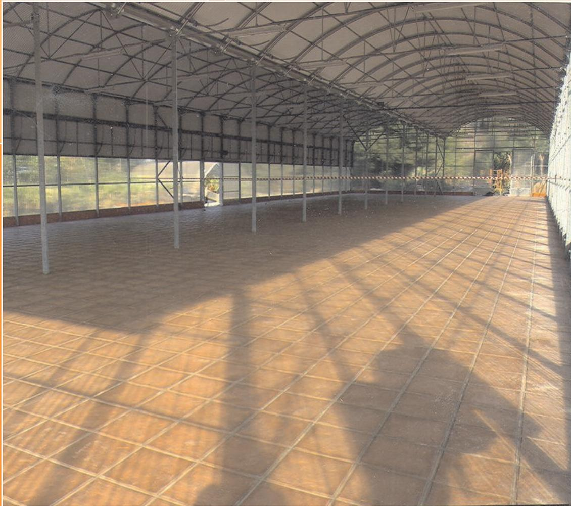
El pavimento de exterior se ha de colocar a "pique de paleta" sobre mortero de cal y cemento evitando huecos o vacios en el extendido del mismo. No se debe "lechar", ya que sus texturas antideslizantes propiciarían el agarre de la lechada dificultando su posterior limpieza.
